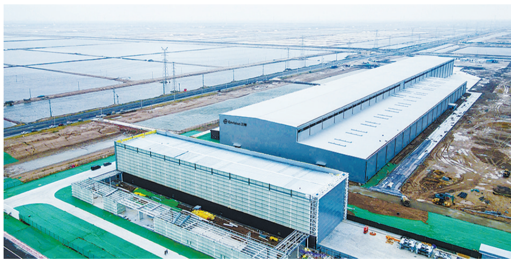
滨州远景叶片与智能风机装备制造北方基地项目现场
