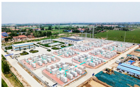
山东征浩资源再生有限公司阳信县独立储能电站项目
