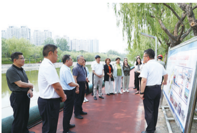
黄河十五路新立河清淤工程现场。
