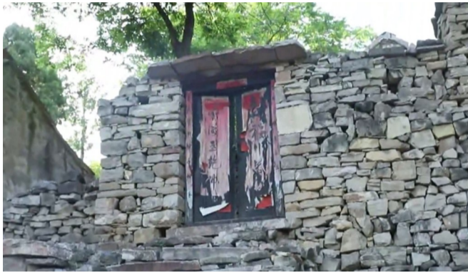
淄博临淄区许家村的一座普通民房里,有一个深深的地道,它通向北海银行地下印刷所。
