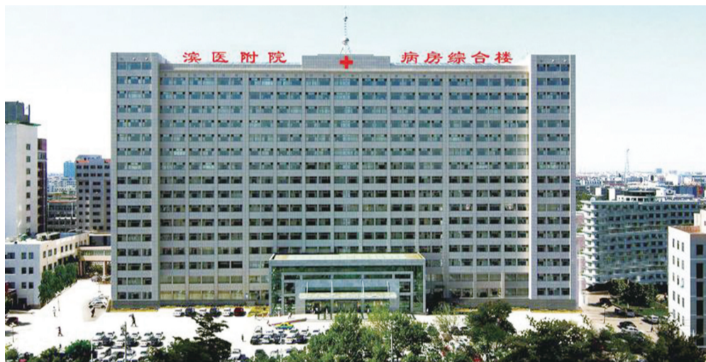
滨州医学院附属医院病房综合楼(鲁班奖)。
