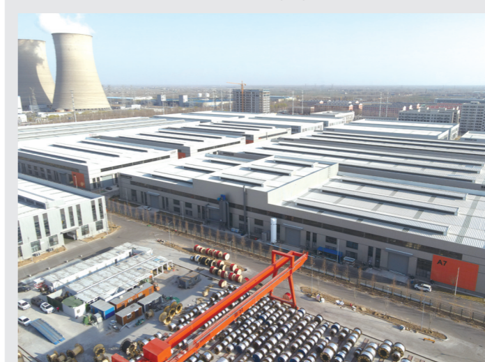
亨通(惠民)电能科技有限公司高端铝及铝合金电缆项目
