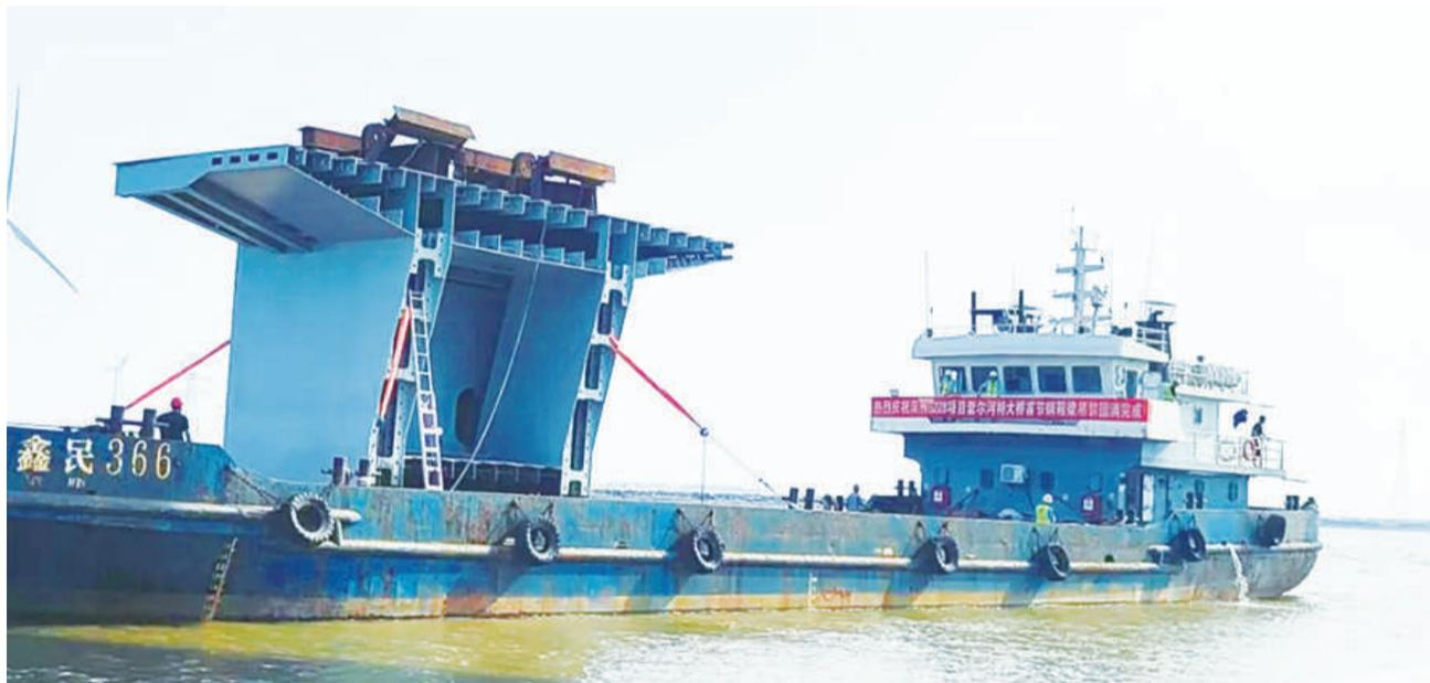
8月30日,G228 丹东线滨州段套尔河特大桥首节钢混结合段顺利吊装。这标志着套尔河特大桥正式迈入主桥合拢施工环节。
