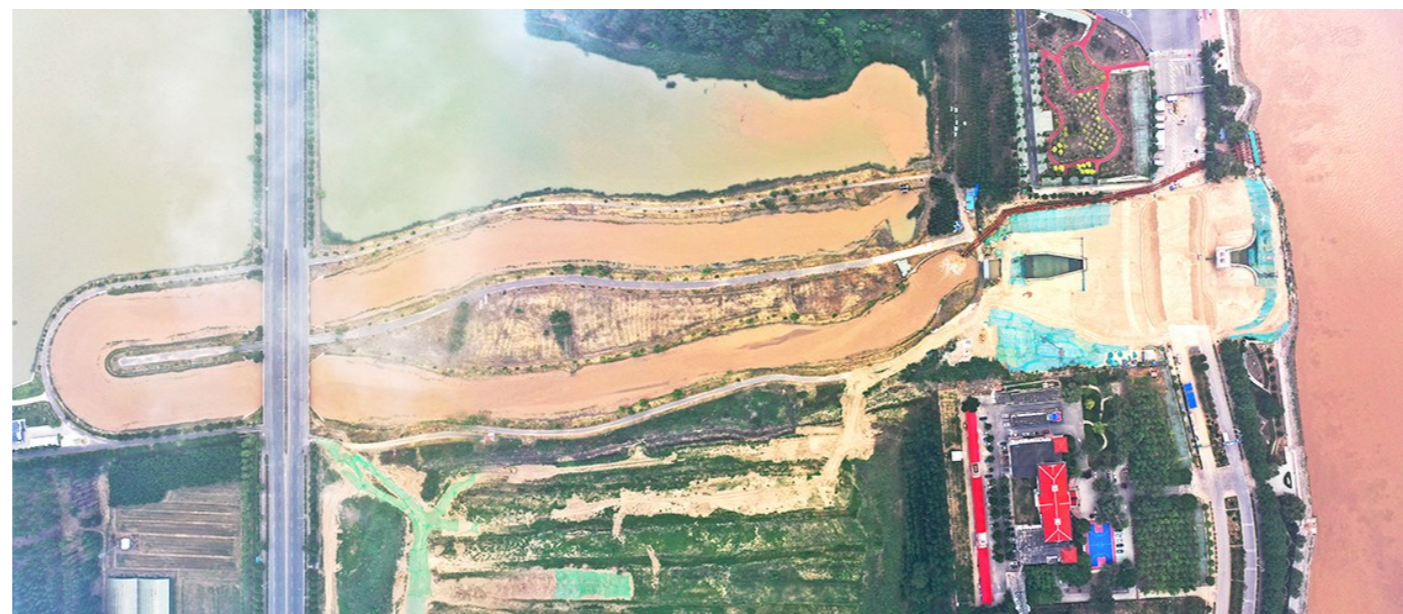
张肖堂引黄灌区沉沙池
