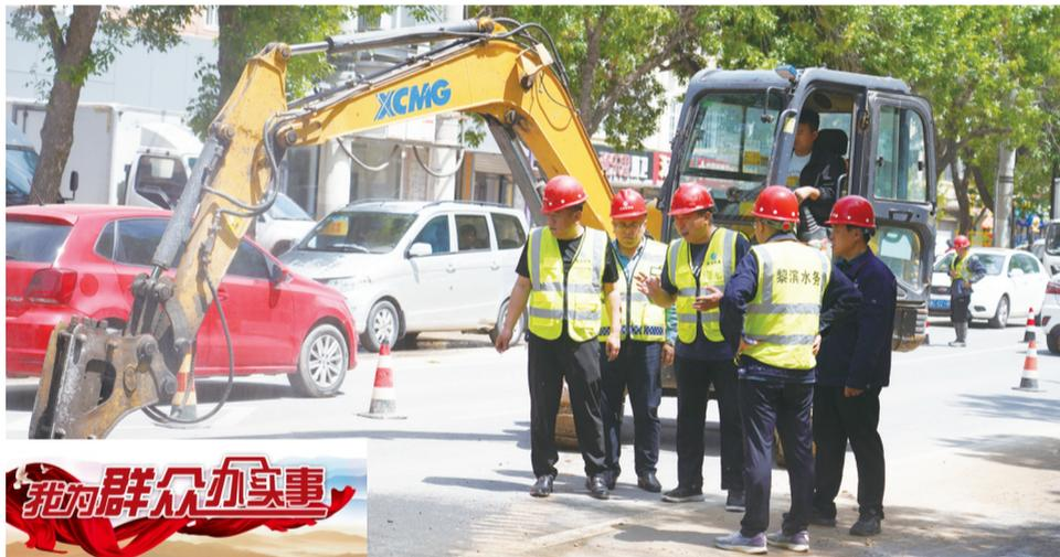
抢修现场,施工人员密切合作,挖掘机、铲土机不停运转,各项抢修工作紧张有序地进行。经过连夜排查,2日凌晨2时确定受损的供水管道位置,(漏损管线为1981-1982年建设的灰口铸铁管),
