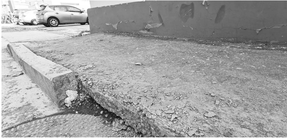
不堪。扫清表层的碎渣后,露出了混凝土道路的内部结构。
